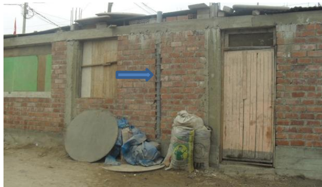
Figura No.08.- Muro con tubería de desagüe de 10cm.
