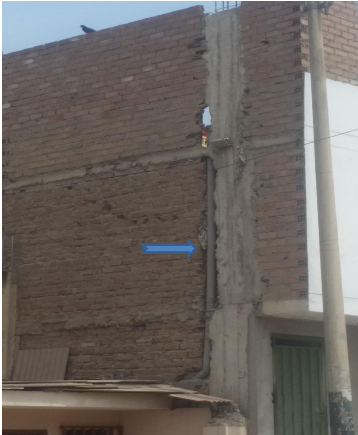
Figura No.09.- Muro con tubería de desagüe de 10cm.
