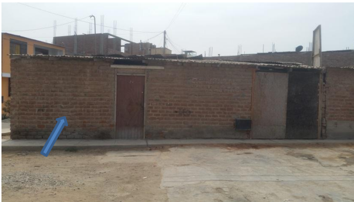
Figura No.10.- Muro con unidades de albañilería artesanales.
