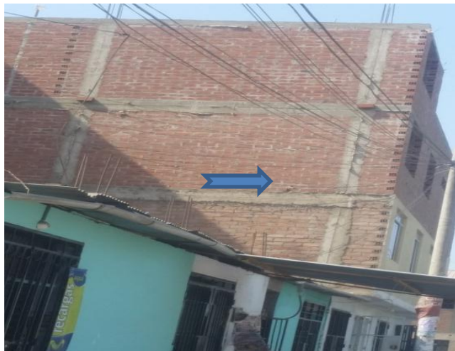
Figura No.05.- Muro portante de ladrillo pandereta
