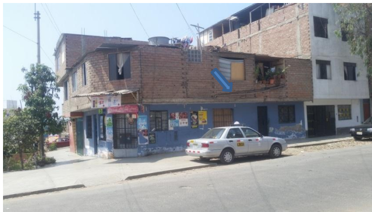
Figura No.07.- Muro portante de ladrillo pandereta picado horizontalmente
