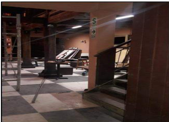
Vista interior del primer piso.
