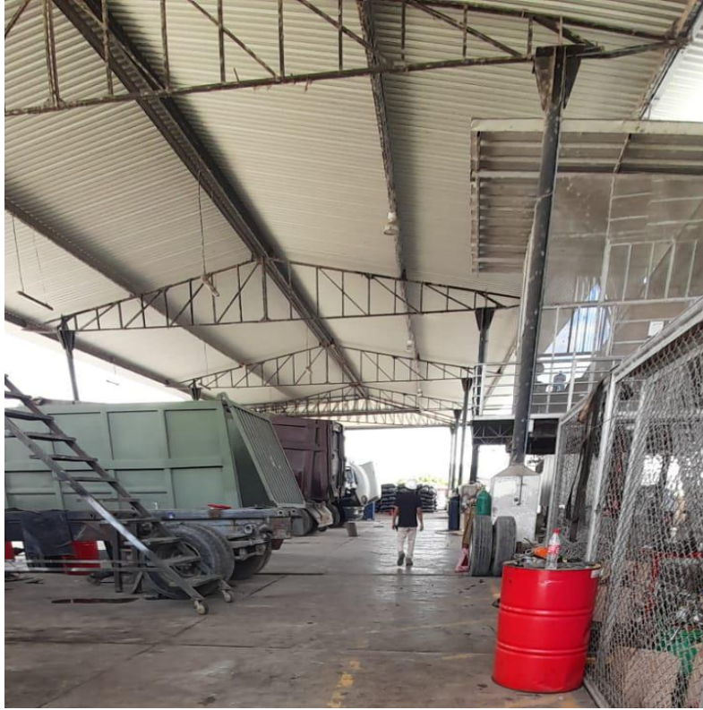
Nota. Inspección de tractocamiones en mantenimiento correctivo
