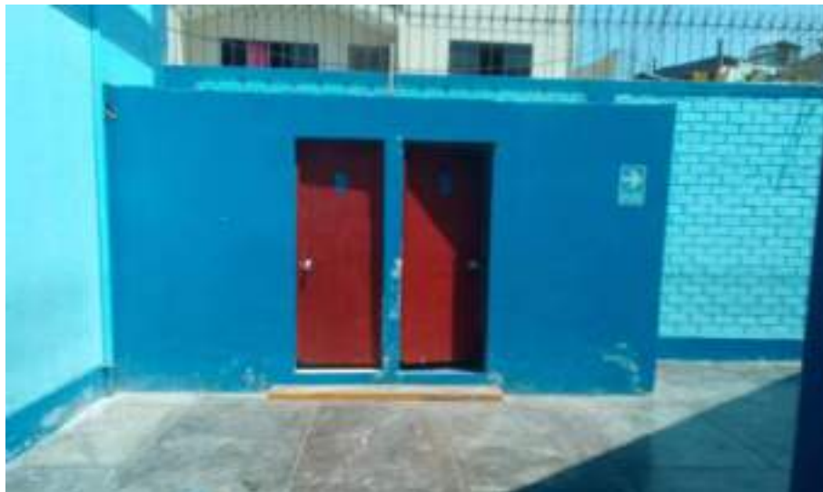
Figura 5: servicios higiénicos del colegio (fuente: de auditoria propia)
