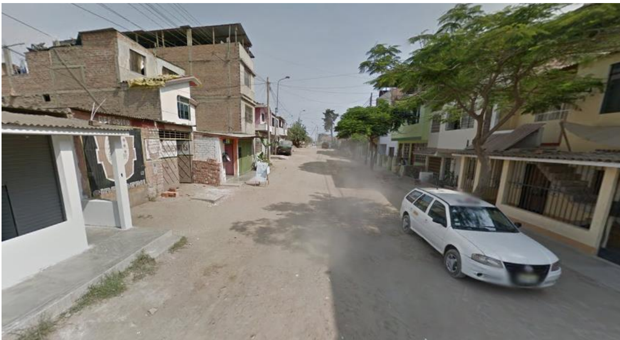
Fotografía 2: Calle D, se observa la existencia de veredas construidas precariamente, y la falta de pavimento.
