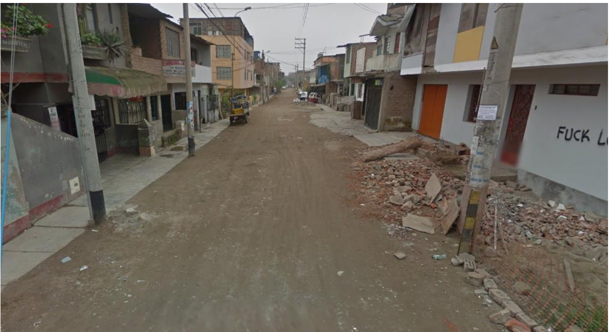
Fotografía 4: Calle E, se observa la existencia de veredas construidas precariamente, y la falta de pavimento.
